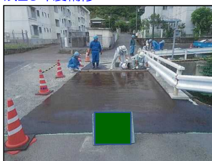
補修状況(舗装打換え)
