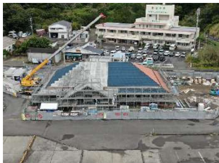
整備中の「加計呂麻ターミナル」西側
