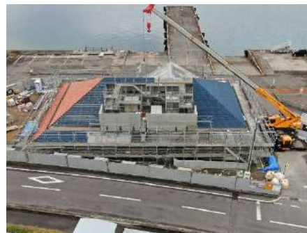
整備中の「加計呂麻ターミナル」東側
