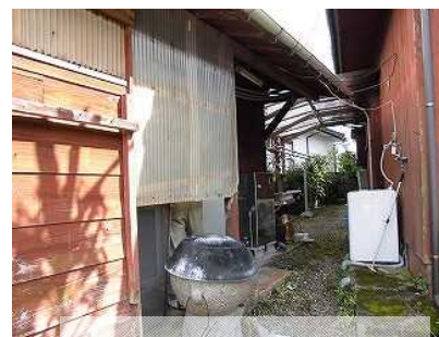
風呂場(敷地内離れ)
