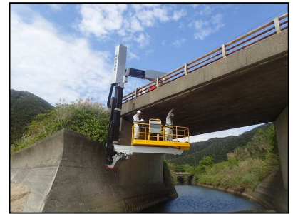
橋梁点検車点検
