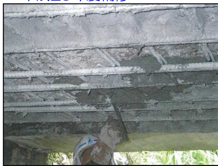
補修状況(断面修復)
