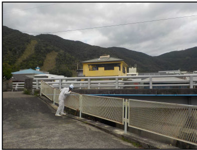
「通常点検」 日常パトロール
