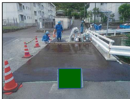
補修状況(舗装打換え)
