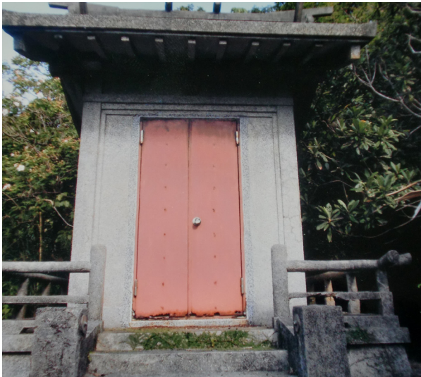
正面からみた奉安殿
