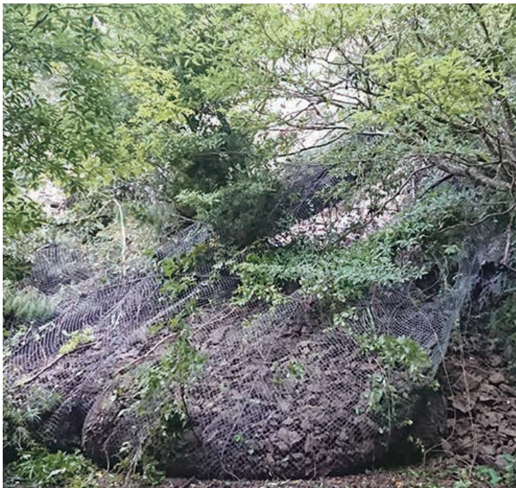
林道勝浦東線の土砂災害
