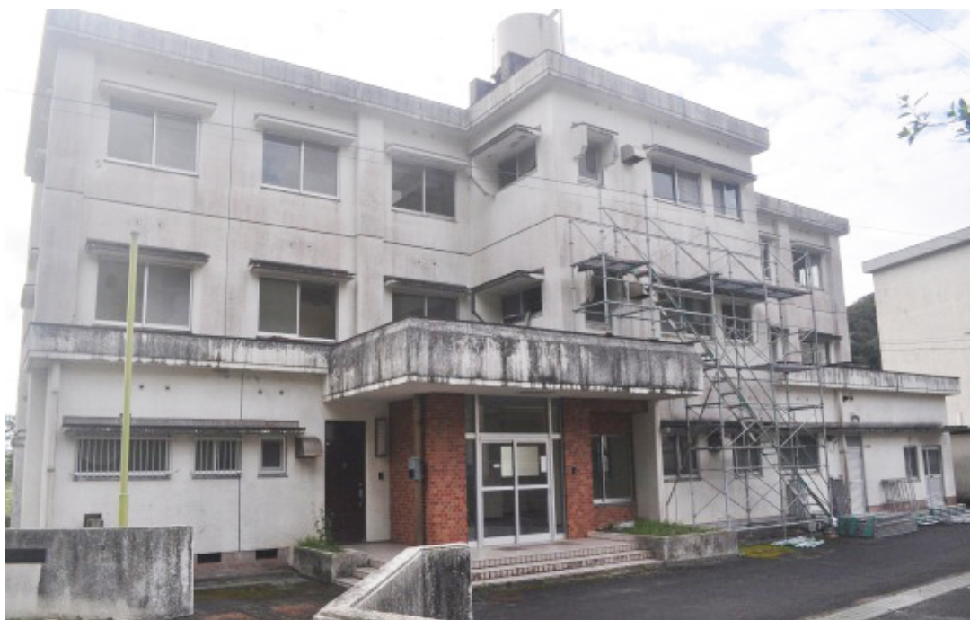
古仁屋高校の寮として改修中
