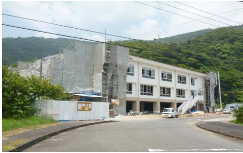
工事中の阿木名小中学校体育館
