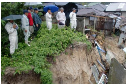
11月2日の豪雨による被災箇所を調査する本町議会議員（11月9日）
