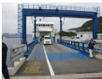
安全性に配慮した現在のフェリー発着場所
